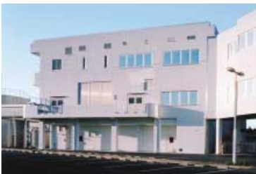
都田製作所第2棟
