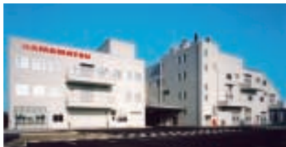
本社工場新第11棟、新第12棟
