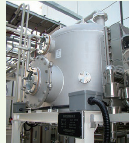
廃酸濃縮装置
