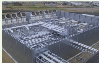
コージェネレーション設備
