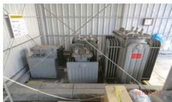
PCB廃棄物の搬出の様子
