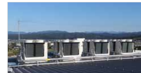
更新した空調熱源機器
