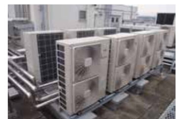
更新後の機器
