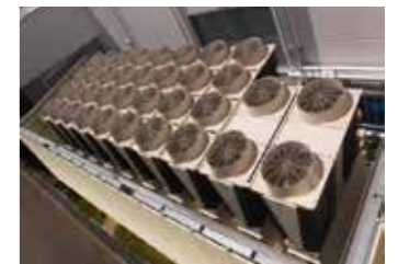
更新した空調熱源機器
