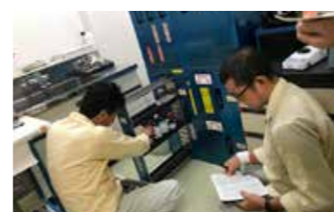
薬品庫の点検
