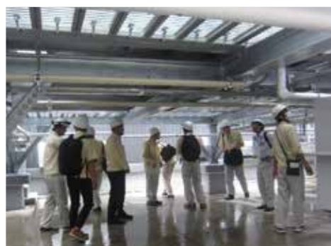
排ガス洗浄装置を床下より確認
