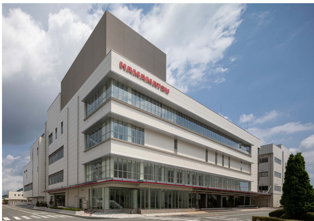
豊岡製作所 新5棟 外観
