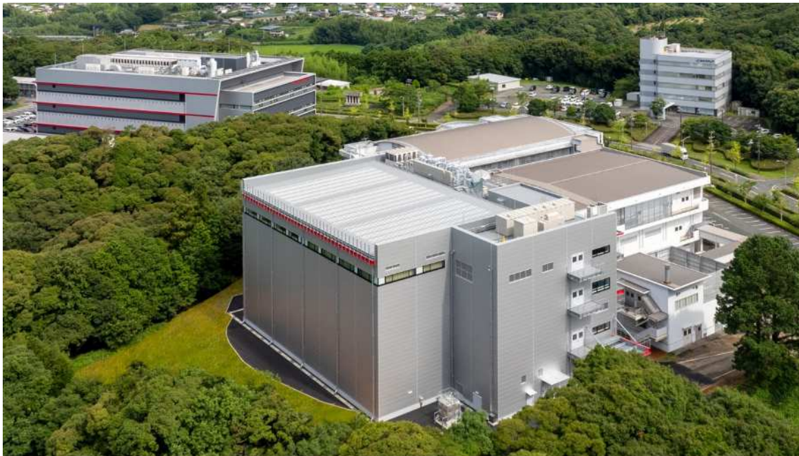
都田製作所 4 棟 外観
