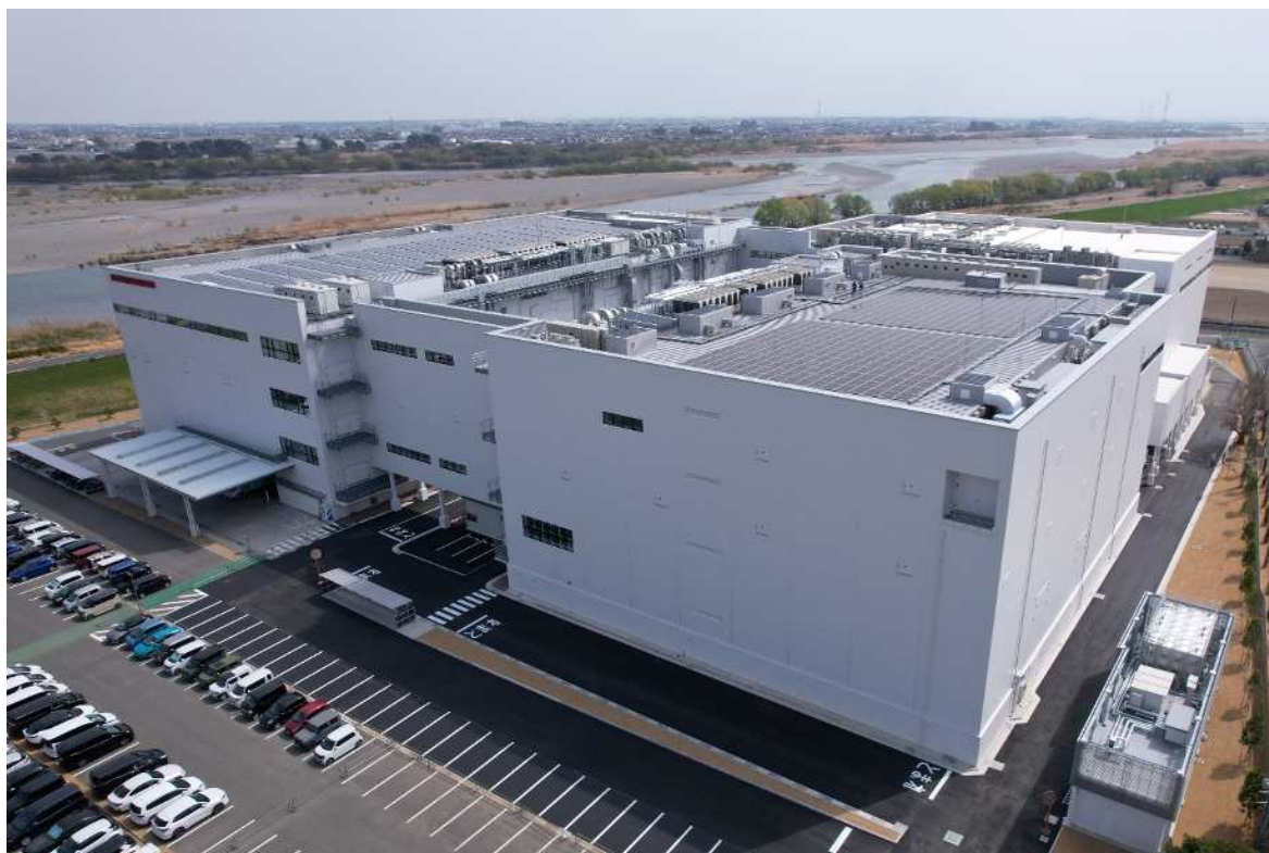
新貝工場 3 棟 外観
