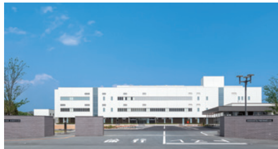
▲豊岡製作所新棟外観
