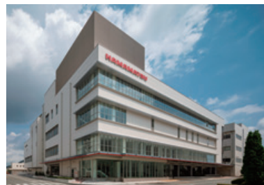
▲豊岡製作所新棟外観
