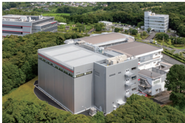
▲都田製作所新棟外観
