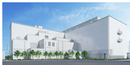
本社工場新5棟
