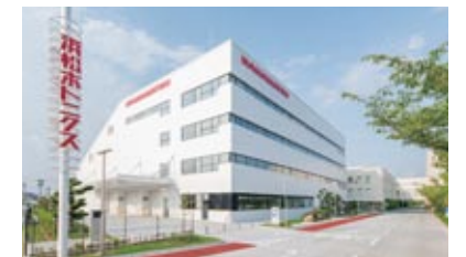
本社工場14棟 外観
