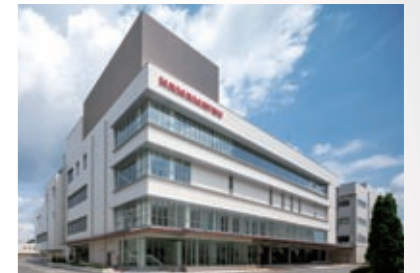
豊岡製作所新5棟 外観
