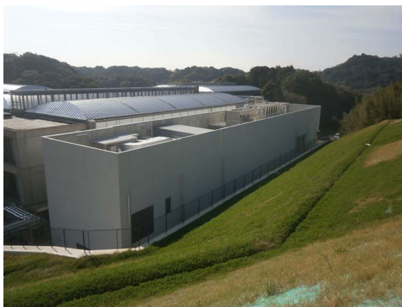
レーザー照射棟
