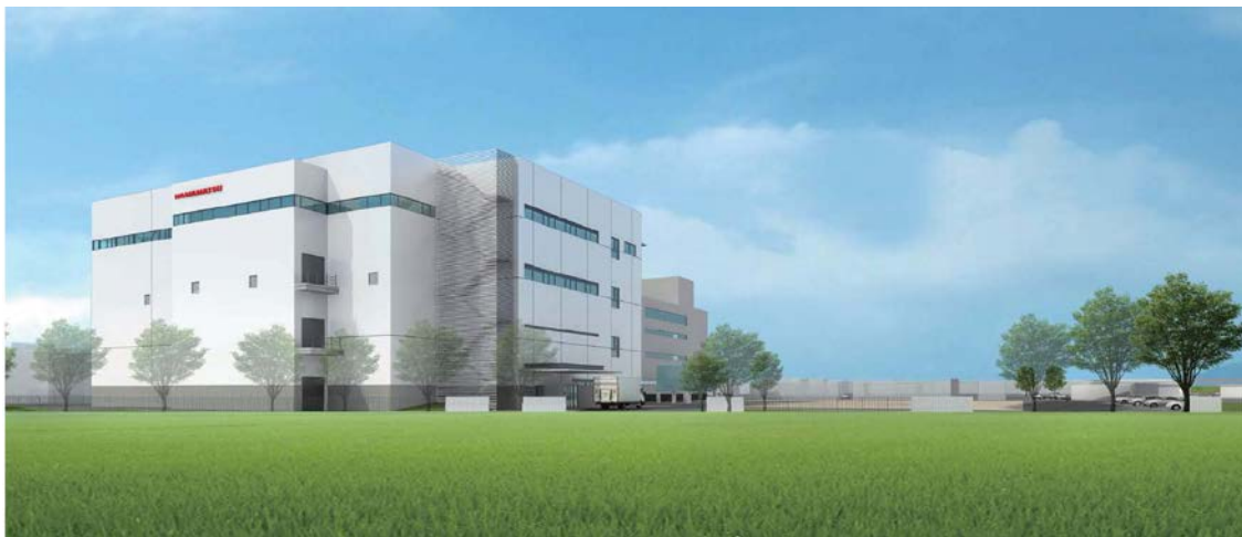
新貝工場 1棟 外観
